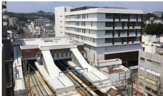
神戸電鉄鈴蘭台駅橋上駅舎化工事
