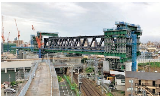
淡路駅周辺連続立体交差工事
