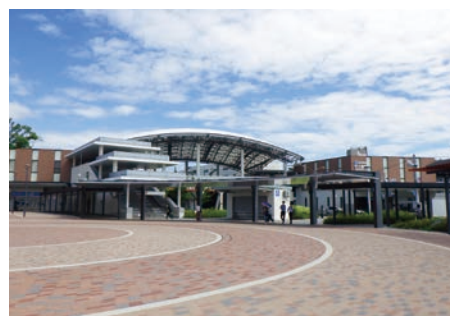
安全・快適な駅への改良
