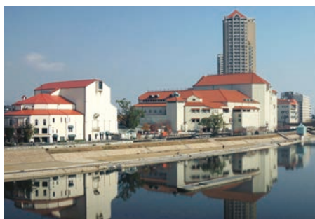
耐震・設備改修
