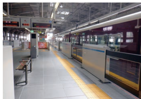
安全な駅への改築
