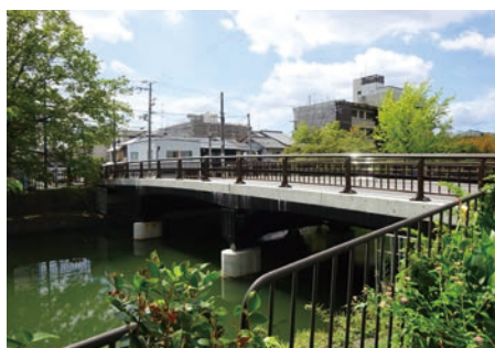
土木遺産橋梁の改修・耐震補強
