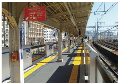
安全な駅への改築
