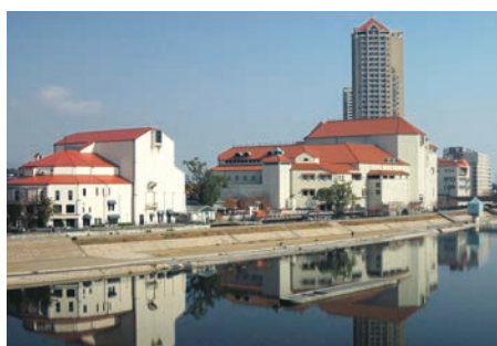
耐震・設備改修
