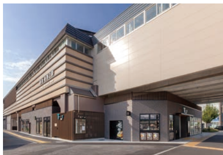
高架化事業・高架下商業施設
